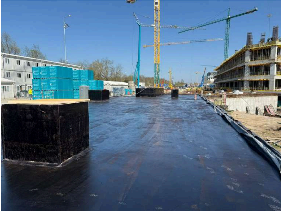
2026.04.16 -Sistem complet de izolatie anvelopanta
