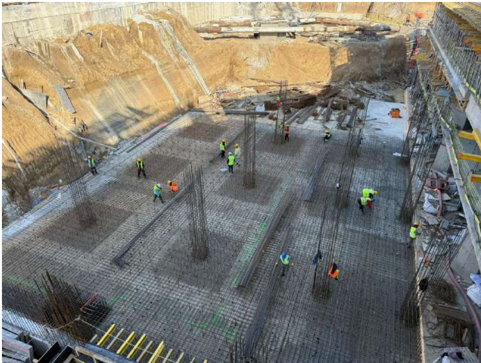
2026.04.16 - Lucrari de armare, zona MH
