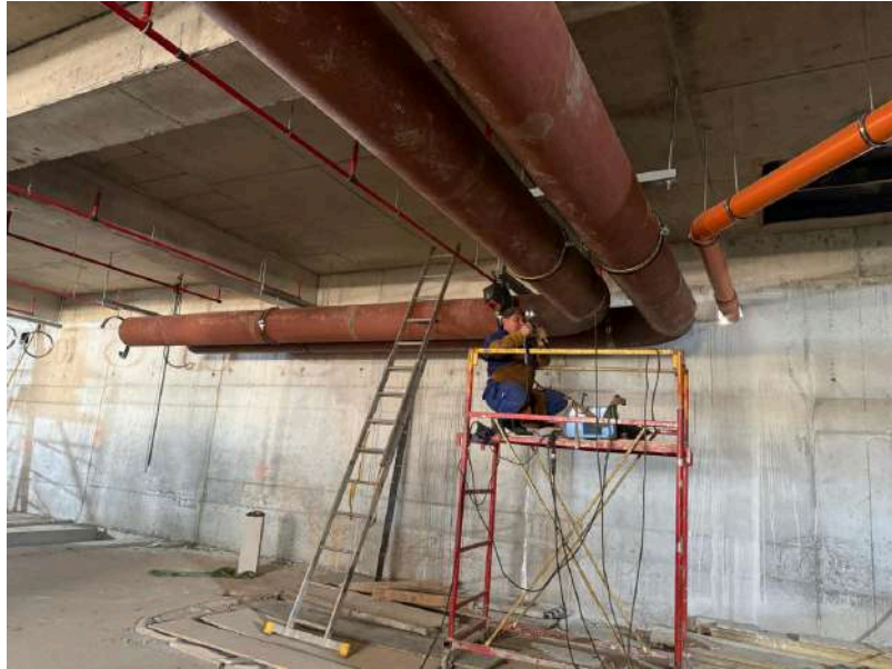
2026.04.17 -Instalatii mecanice zona MH
