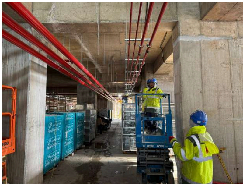
2026.04.15 -Instalatii mecanice zona MH
