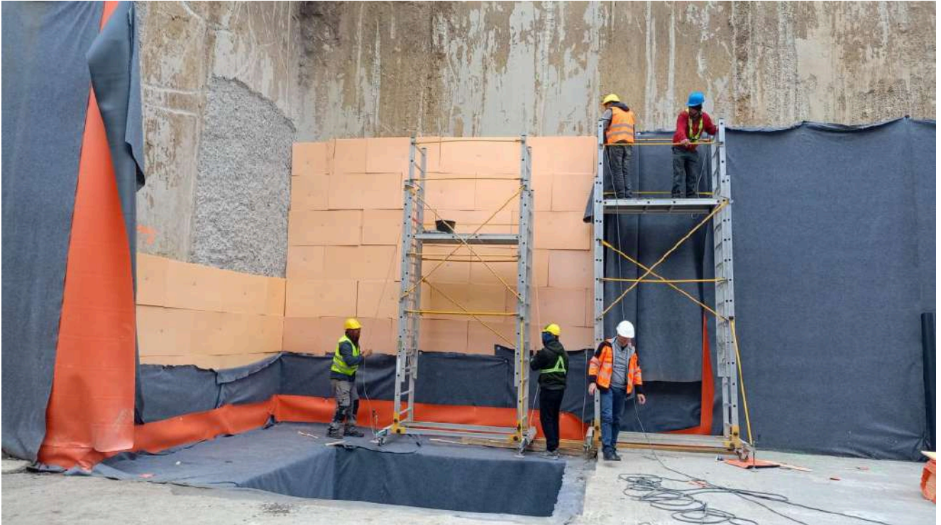
2026.04.22 - Sistem complet de izolare incinta
