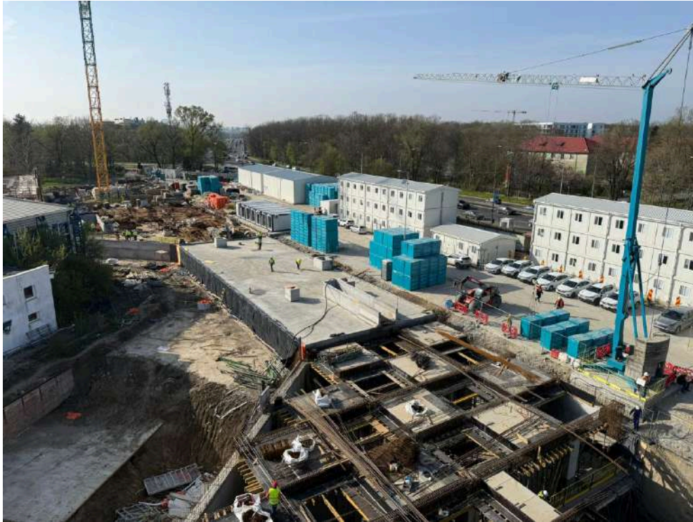
2026.04.15 - Vedere generala, zona TS
