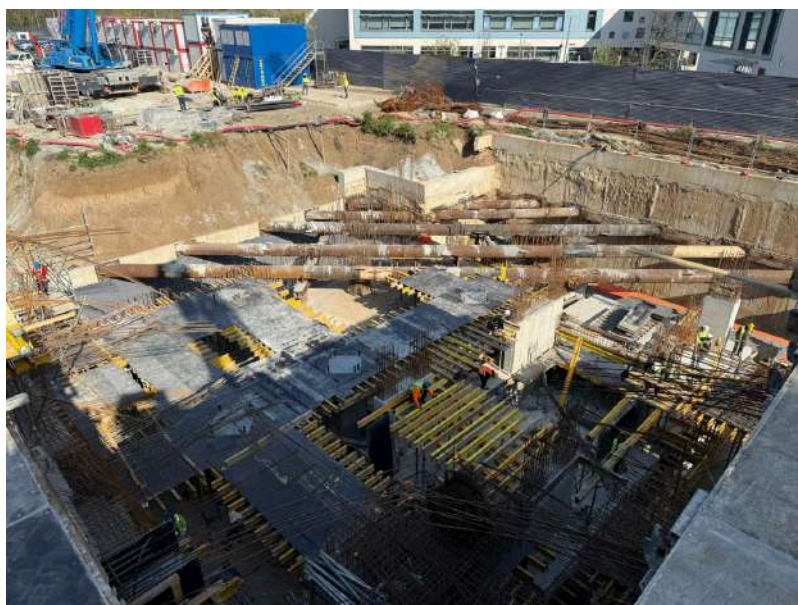
2026.04.16 - Lucrari de cofrare, armare, zona MH
