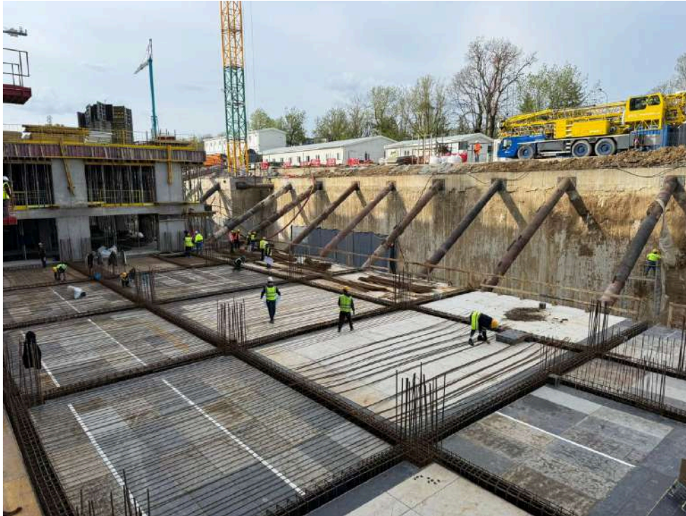
2026.04.21 - Lucrari de cofrare, armare, zona MH
