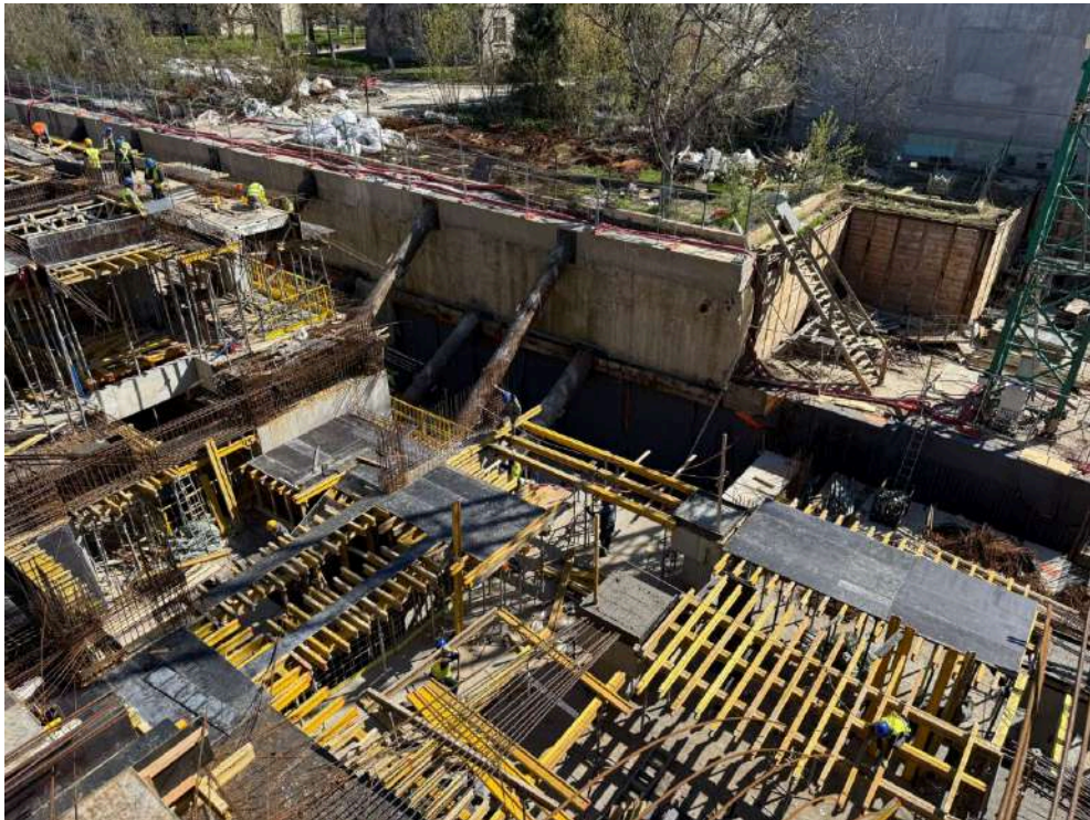
2026.04.07 - Lucrari de cofrare, armare, zona MH
