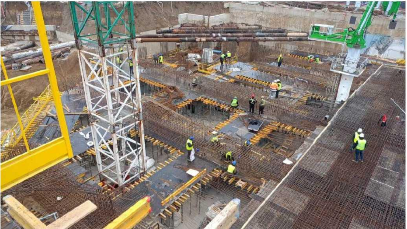
2026.03.14 - Lucrări de cofrare, armare, zona MH
