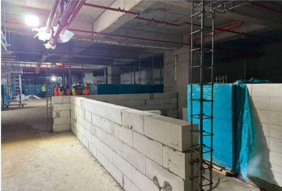
2026.03.31 - Instalații mecanice și electrice zona TS
