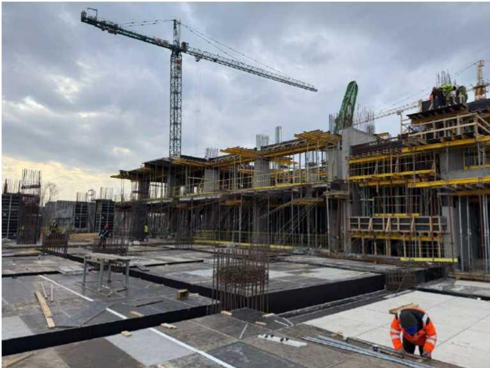
2026.03.19 - Lucrari de cofrare, zona MH
