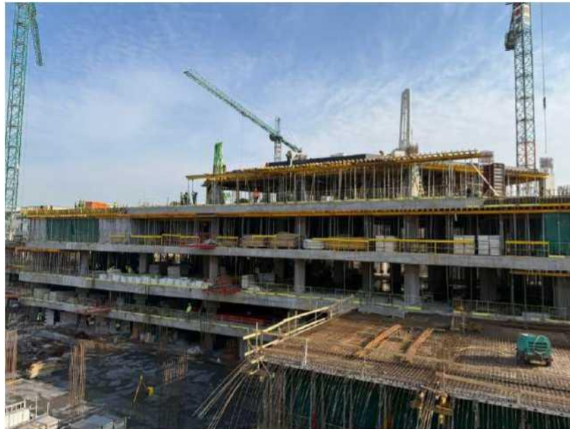
2026.03.05 - Vedere de ansamblu zona MH
