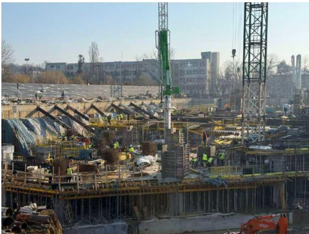
2026.03.03 - Vedere de ansamblu zona MH
