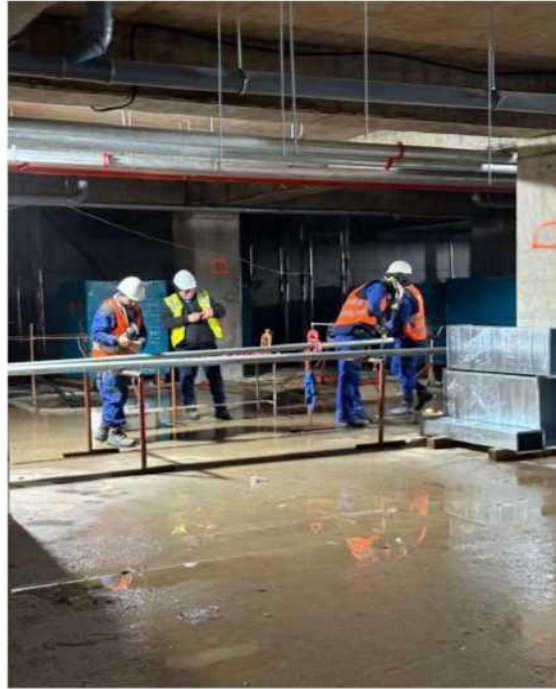
2026.03.04 -Instalații mecanice zona TS
