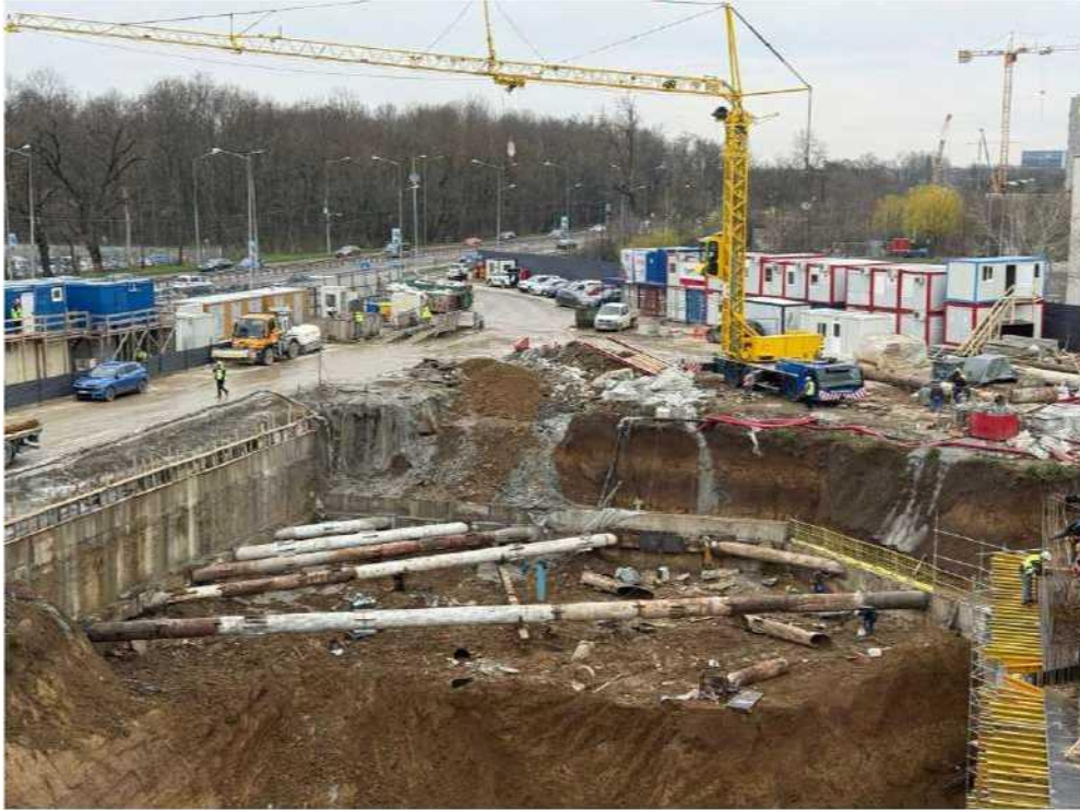
2026.03.31 Montare sistem de sprijiniri cu spraituri metalice zona MH
