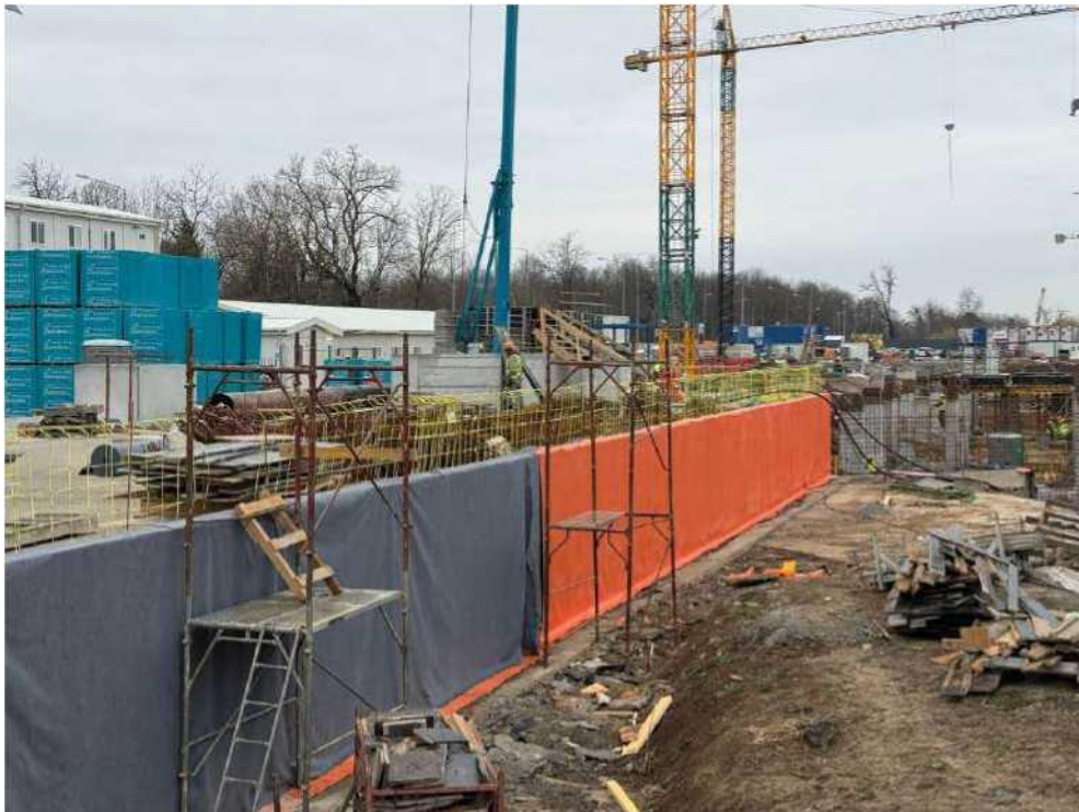
2026.03.21 - Sistem complet de izolatie incinta
