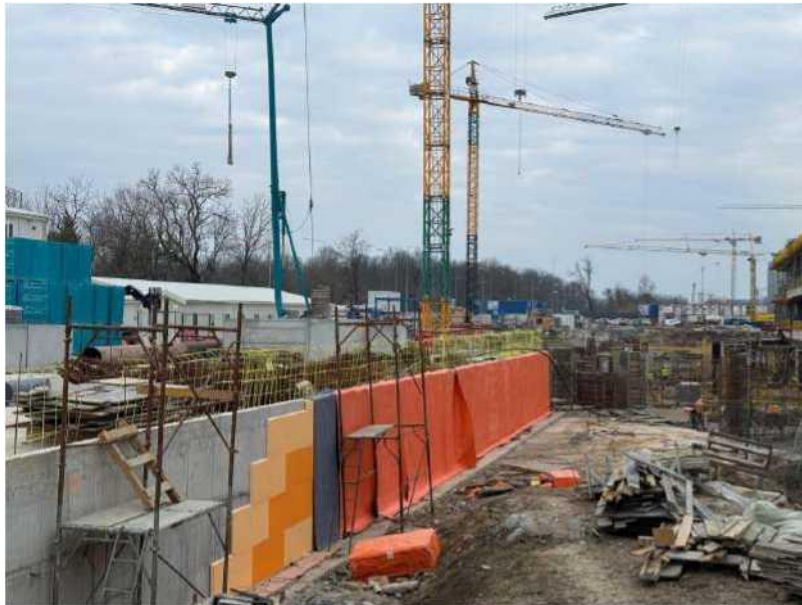
2026.03.19 - Sistem complet de izolație incinta
