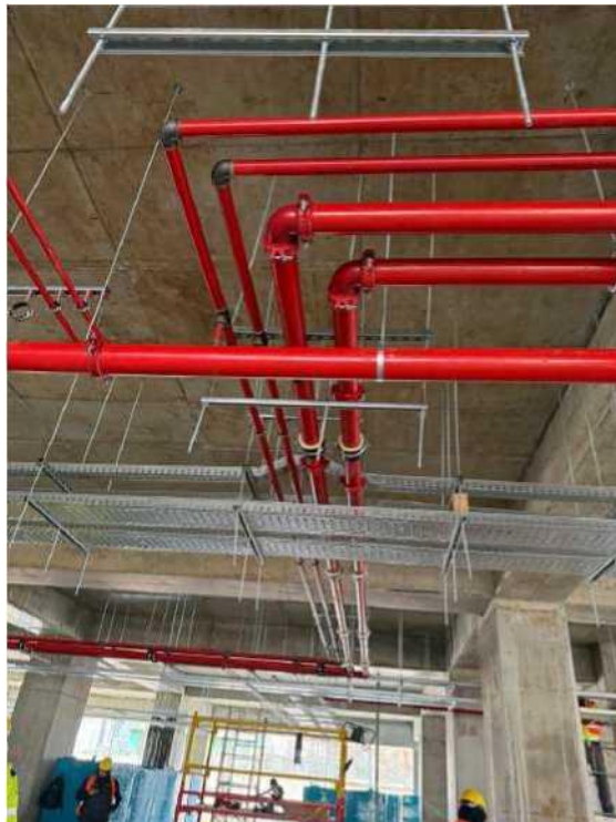
2026.03.21 - Instalații mecanice și electrice zona MH
