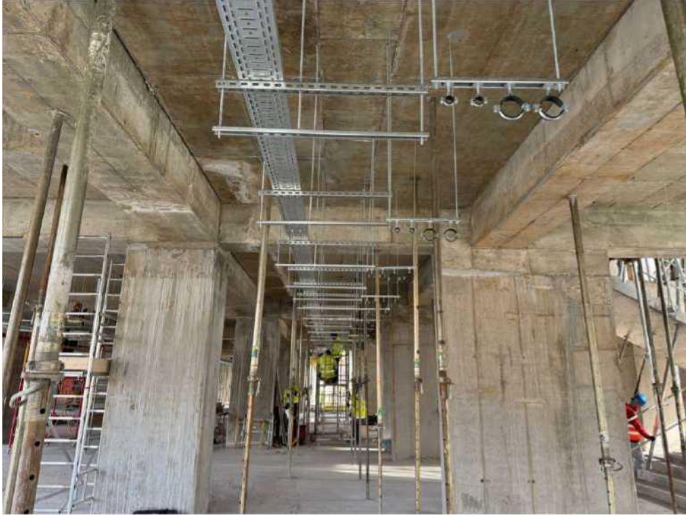
2026.03.17 -Instalații mecanice zona MH
