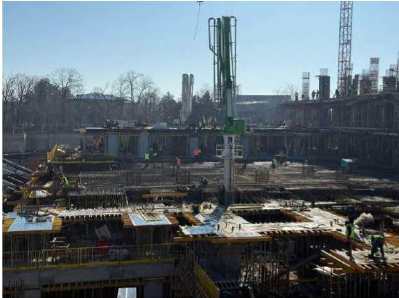
2026.03.09 - Vedere de ansamblu zona MH
