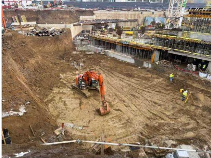
2026.03.01 - Excavatii de mare adancime, zona MH
