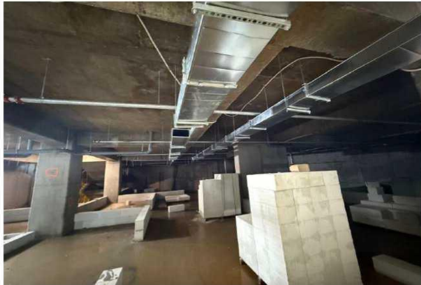
2026.03.05 -Instalații mecanice zona TS
